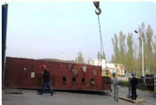
淘汰燃煤鍋爐
