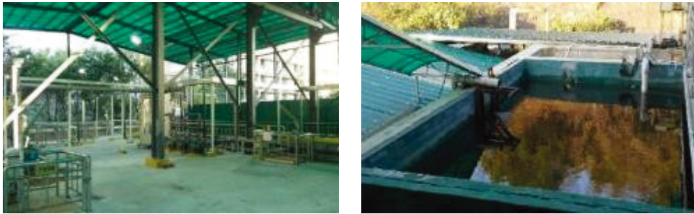
深圳廠區內的生活廢水處理設備。處理後水質年回用量可達到40萬噸／年。
