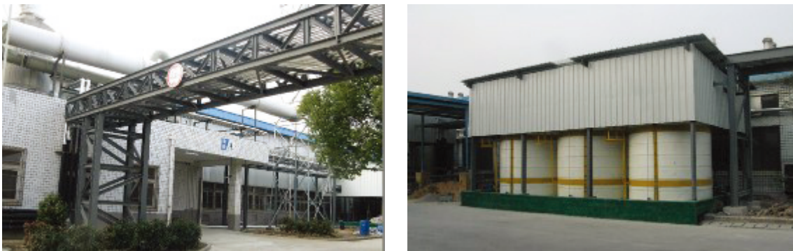
改造後架空輸送的廢水運輸管與架設在原中轉池上方的廢水儲藏桶。
