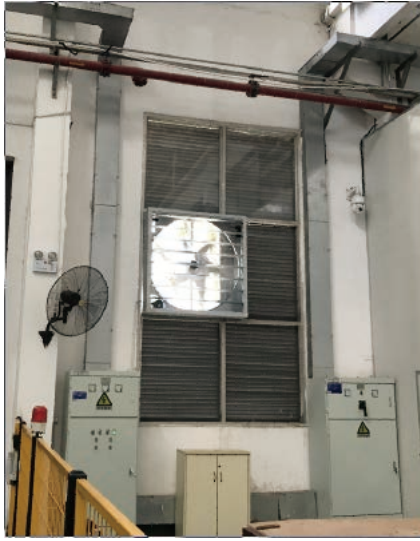
檢測試驗中心廠房窗戶並安裝負壓風機、加裝水冷空調，改善高溫作業環境
