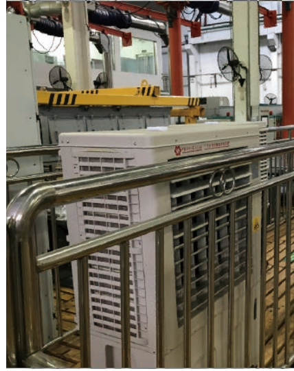
檢測試驗中心廠房窗戶並安裝負壓風機、加裝水冷空調，改善高溫作業環境
