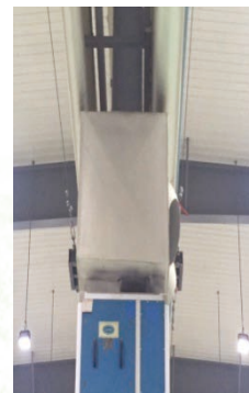
製造中心高空作業條件改善 (增加系安全帶的鋼絲繩)
