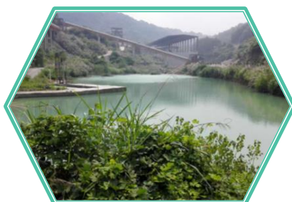
江西亚东矿山一级沉淀暨蓄洪调节池
