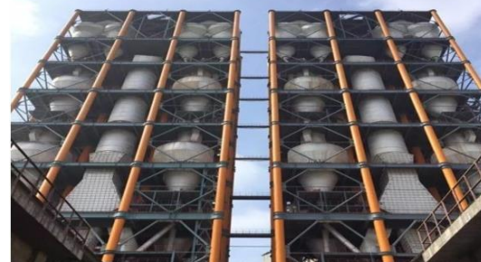
江西亚东#5#6窑 六级旋风预热器及脱硝分解炉、煤粉分级燃烧设备
