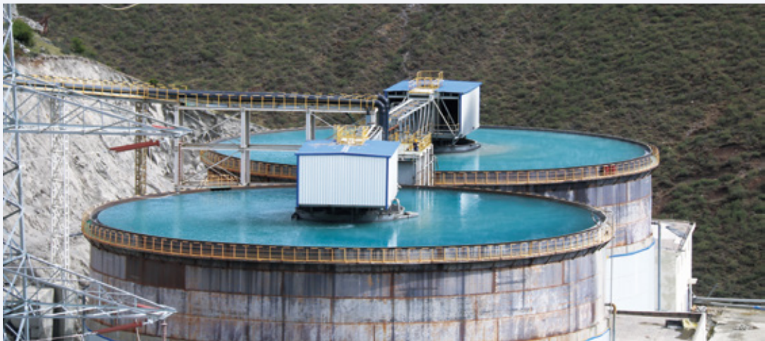
西藏華泰龍新建設備
