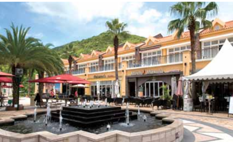
DB North Plaza 愉景北商場
