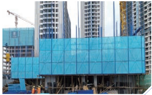
爬升架安裝過程
