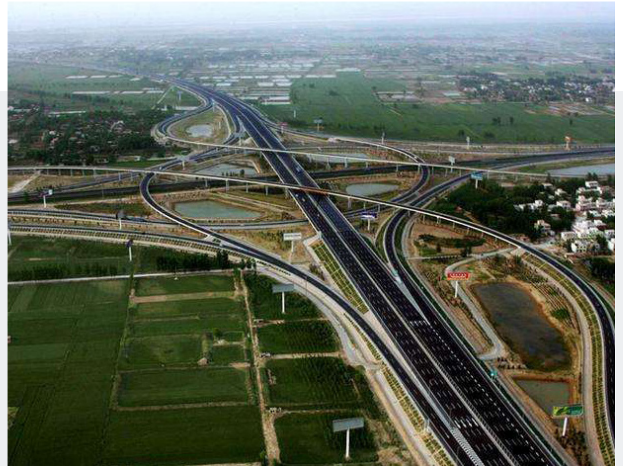
圖6.2-3 國銀租賃支持港澳高速湖北省北段，助力基礎設施完善
