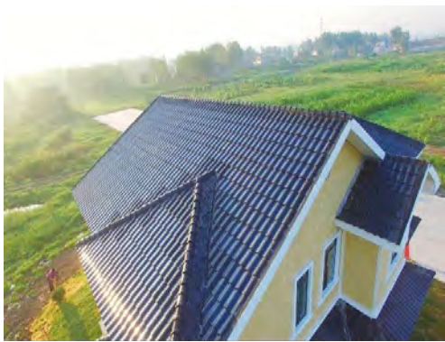
Photovoltaic tile project in Si County, Anhui 安徽泗縣光伏瓦項目
