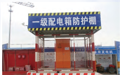
配電箱防護棚
