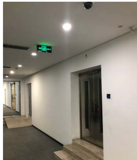
總部辦公大樓緊急逃生通道及防火門
