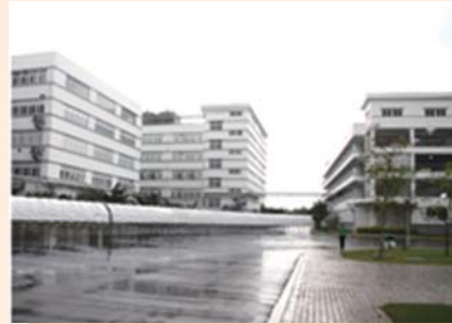
越南廠房 — 興建有蓋人行道
