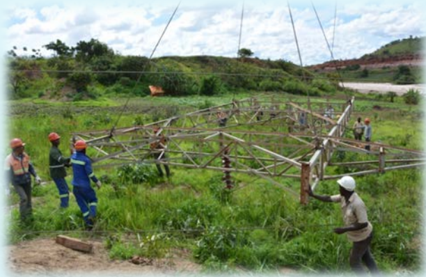
電路搶修現場
