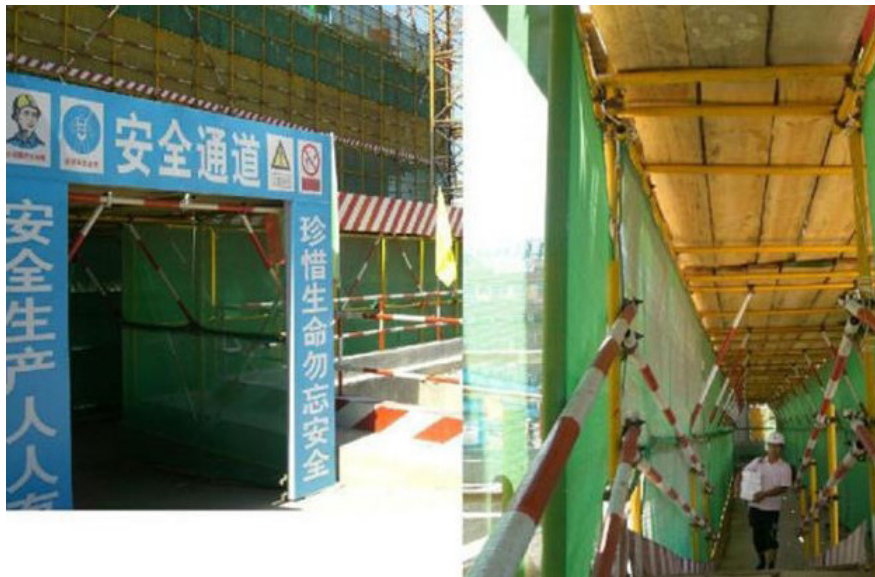
施工場地會設置安全通道
