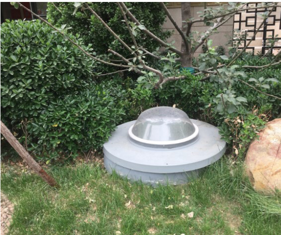
在建工程項目設置太陽能採集燈
