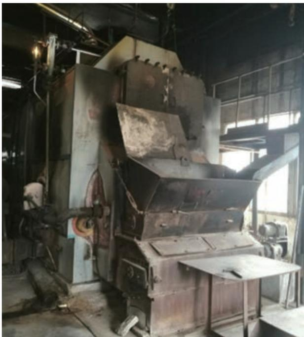
中山同得仕的鍋爐及相關設備燃燒生物燃料，從而產生熱能及蒸氣，用於生產過程中的衣物熨燙及員工宿舍的熱水供應。中山同得仕已增設濾塵器，並定期監察生物燃料鍋爐的運作，以確保生物燃料已完全燃燒。有關安排能降低灰燼、煙霧或塵埃的排放。中山同得仕於員工飯堂也使用天然氣來煮食。
