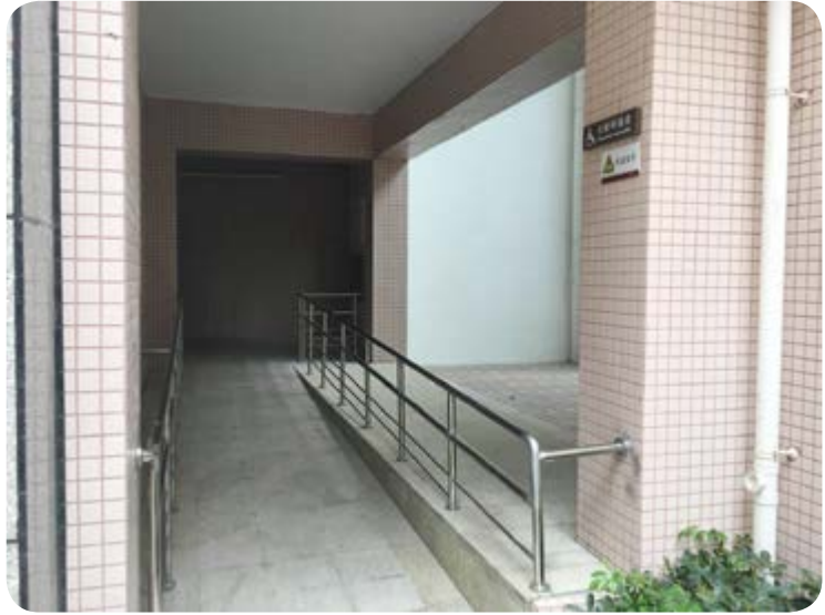
住宅大樓為協助殘障人士出入而設計的斜坡
