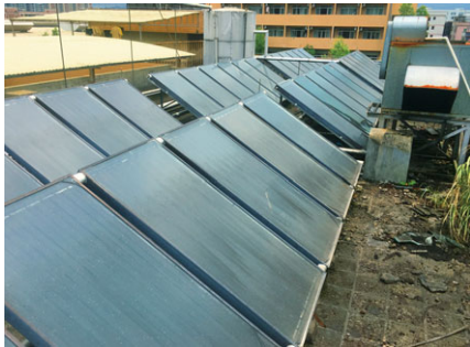
員工宿舍天台上的太陽能發電設備
