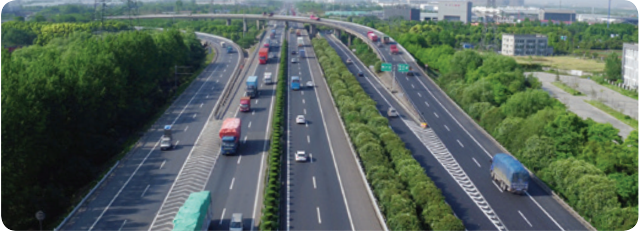
杭州繞城公路
