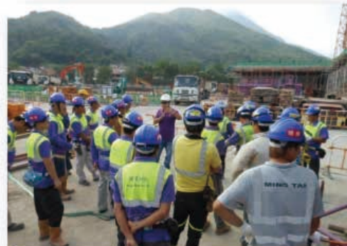
危害識別活動 Hazard Identification Activity
