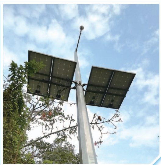
依靠微型風力及太陽能供電的節能監控攝像槍
