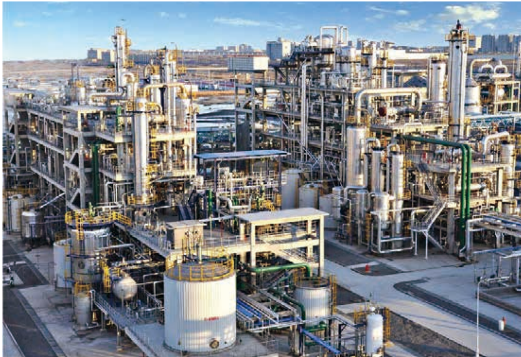
滄州生產基地的己內醯胺生產設施
