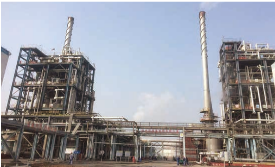
唐山生產基地的苯酚生產設施
