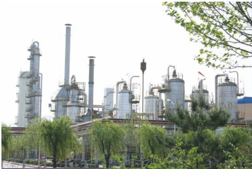
定州生產基地的甲醇生產設施
