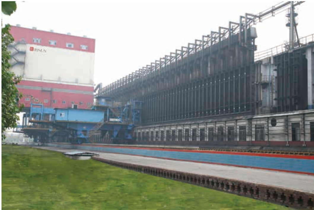
定州生產園區的焦炭生產設施
