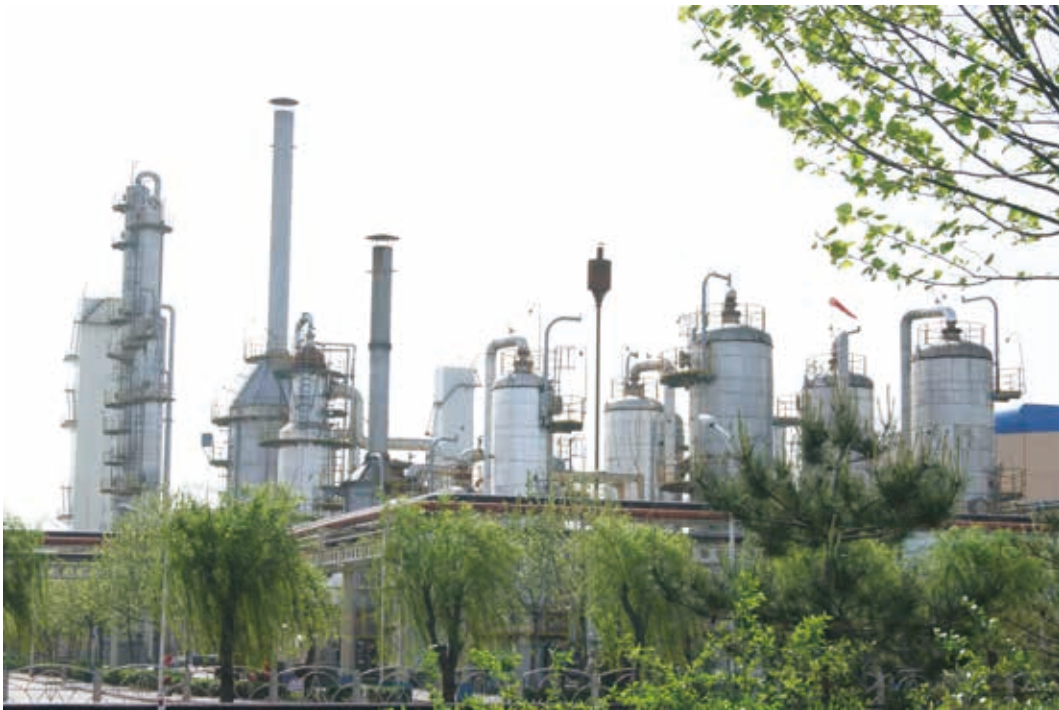
定州生產園區的甲醇生產設施
