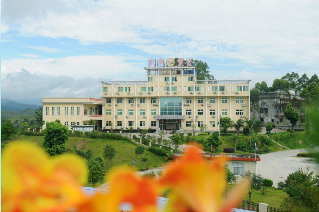
武平紫金矿业有限公司办公楼全景
