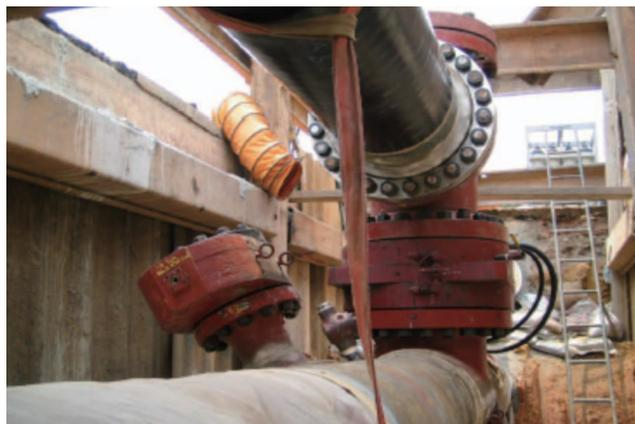
我們的高壓熱鑽孔操作使客戶得以在沒有洩漏氣體及干擾氣流的情況下在現有管道加插分支接件，令我們得以停止輸氣及於短時間內改變所有管道的走向。
