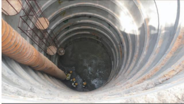
典型的鋼板樁造井產生較多噪音，倘進行試鑽孔工作不得其法，容易令裝置受損。我們提供沉箱造井法，可減少對周邊樓宇及敏感構築物造成的震盪及噪音傷害。
