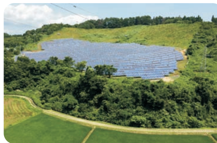
日本1.5兆瓦太陽能發電場
