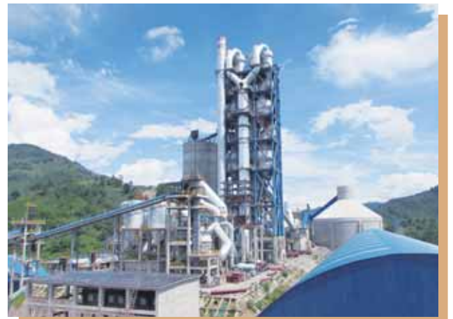
位於雲南省普洱的水泥生產廠
