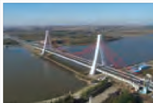
▲ 松原市天河大桥工程 Tianhe Bridge project in Songyuan City
