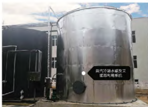
在中国，2018年我们对铜回收车间生产废水系统进行投资改造，建成蒸汽冷凝水回收系统，使冷凝水输送到生产高位水池，进行循环使用。利用该系统可以回收蒸汽冷凝水约达80%，年减少新水用量4万立方米左右。
