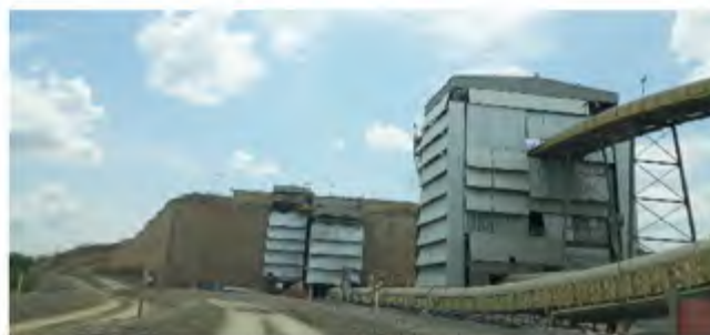
巴西对Boa Vista矿山的碎矿系统进行了封闭,以减少噪音和颗粒物排放。
