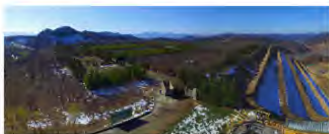
中国三道庄矿区投入资金,对排渣场实行了复垦,截至目前已累计恢复植被面积达143公顷。
