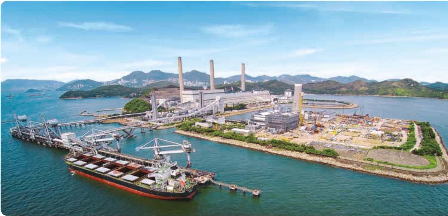
▶ 南丫發電廠正在興建三台新發電機組 L10、L11 及 L12，以提升燃氣發電容量。
