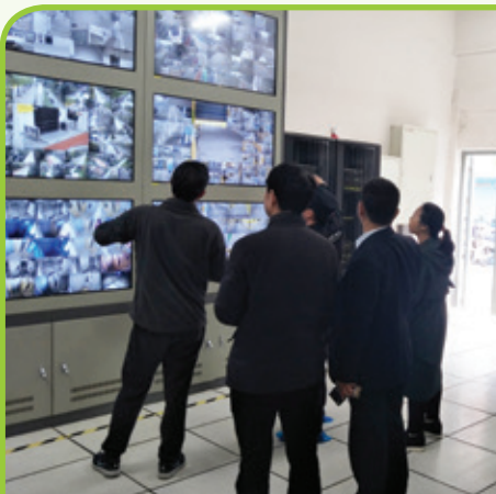
Equipment Room Open Day 設備室開放日
