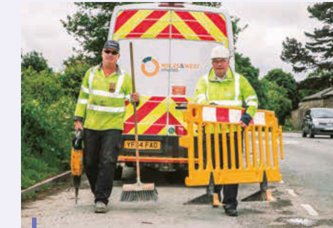
WWU 全年在路邊工地進行不同的緊急及定期保養工作。
