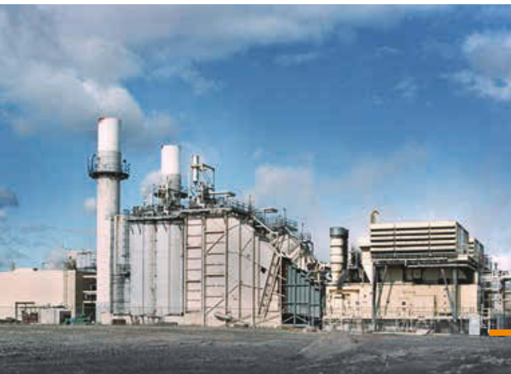
Canadian Power 位於加拿大 Mississauga 的燃氣發電廠。
