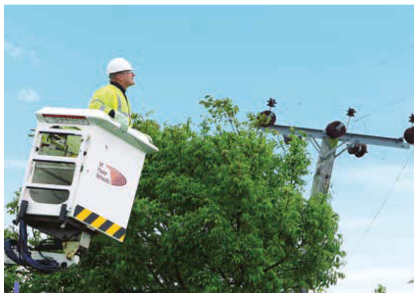
UKPN 工程師進行架空電纜保養，確保公司的供電可靠度領先同業。
