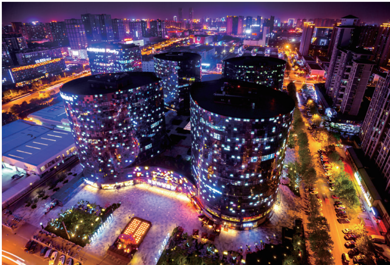
鄭州五棟大樓
