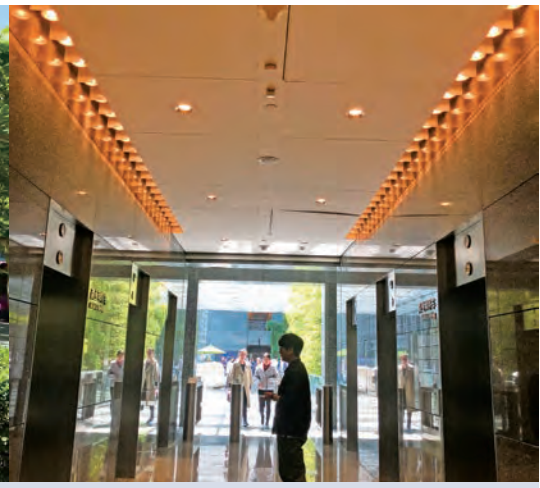
照明光源更換成節能LED光源
