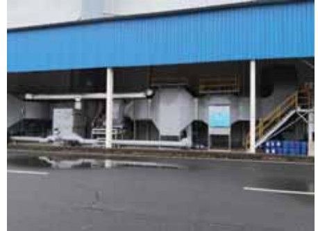
圖中是位於寧波其中一個廠區的噴漆房及廢氣處理設施
