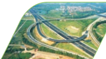
廣州西二環高速公路
