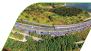
廣州北二環高速公路
