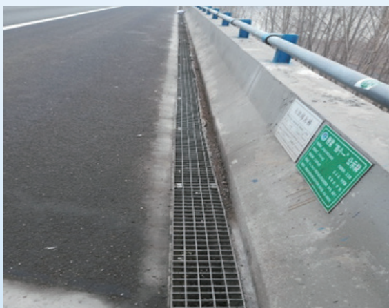
雨水引導及排水系統改造
