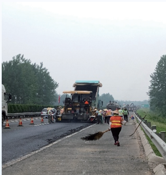
對道路進行預防及修復性養護施工
