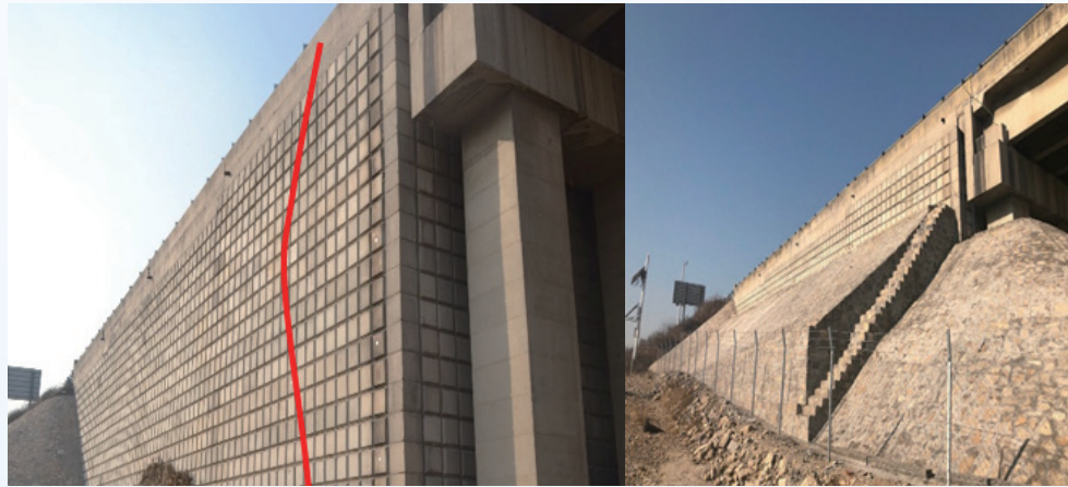
對特定路段加筋擋土牆進行加固維修專項養護施工
