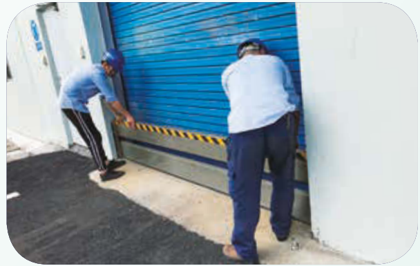
安裝防颱措施
