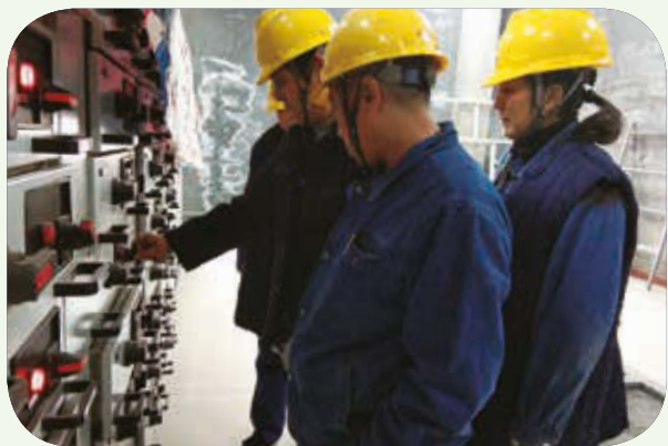
脫硫廢水旁路煙氣蒸發項目現場試驗
