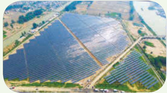
淮陰電廠灰場光伏
