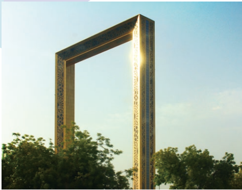
為杜拜的新建築地標「杜拜相框」 (The Dubai Frame) 部署室內無線解決方案
