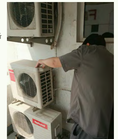
清洗空调机组，提升设备工作效率
