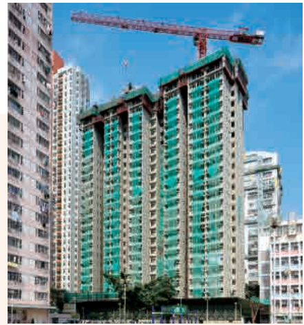
柴灣永泰道公營房屋建造工程
