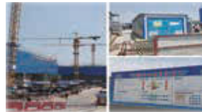
參觀綠色建築施工基地
