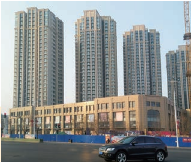
富豪新開門之住宅大樓及商業綜合大樓 — 已落成
