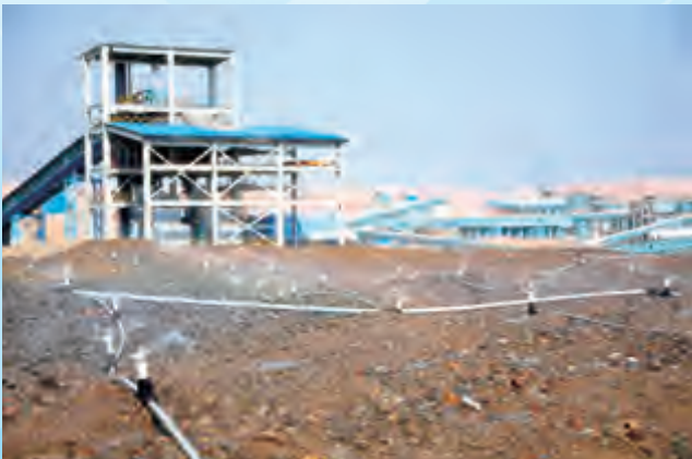
穆利亞希項目堆浸系統1號堆場噴淋作業
