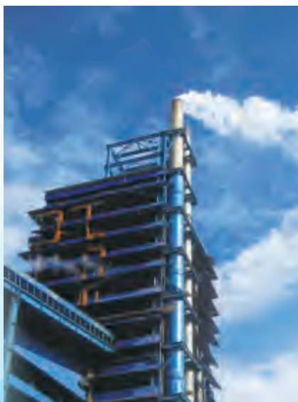
銅冶煉公司ISA爐廠房
