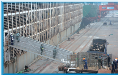
搭建奶牛接卸作業平台
