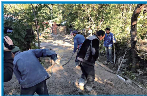
幫助石門子村鋪設通組路
