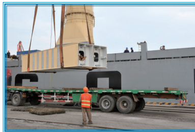
帕德瑪大橋橋梁設備運輸
