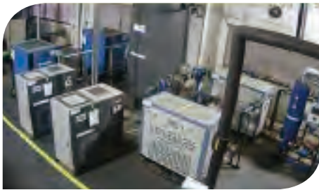
改造：重點設備運行重點監控。
