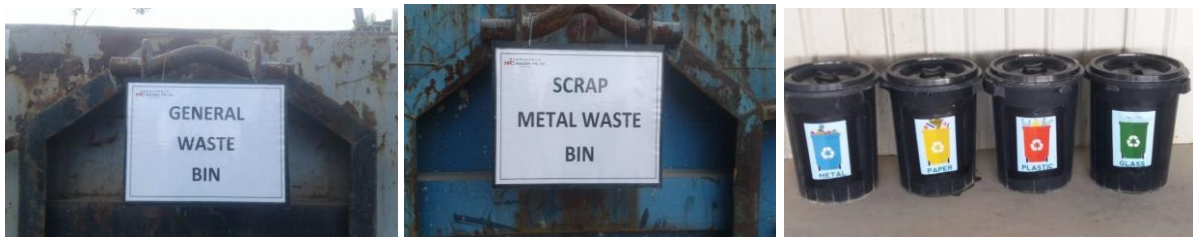
現場隔離及回收廢物
