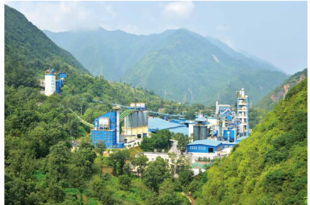
鎮安公司技改後生產線
