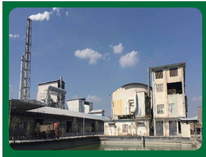
中化雲龍雨水收集池
